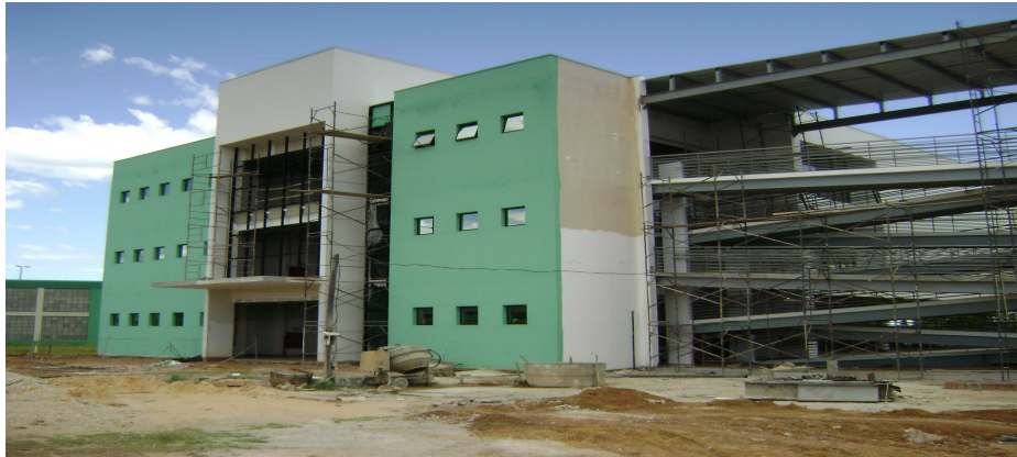
Fotografia 1 – Prédio novo da Biblioteca do Campus de Palmas em construção. Abril de 2010.
