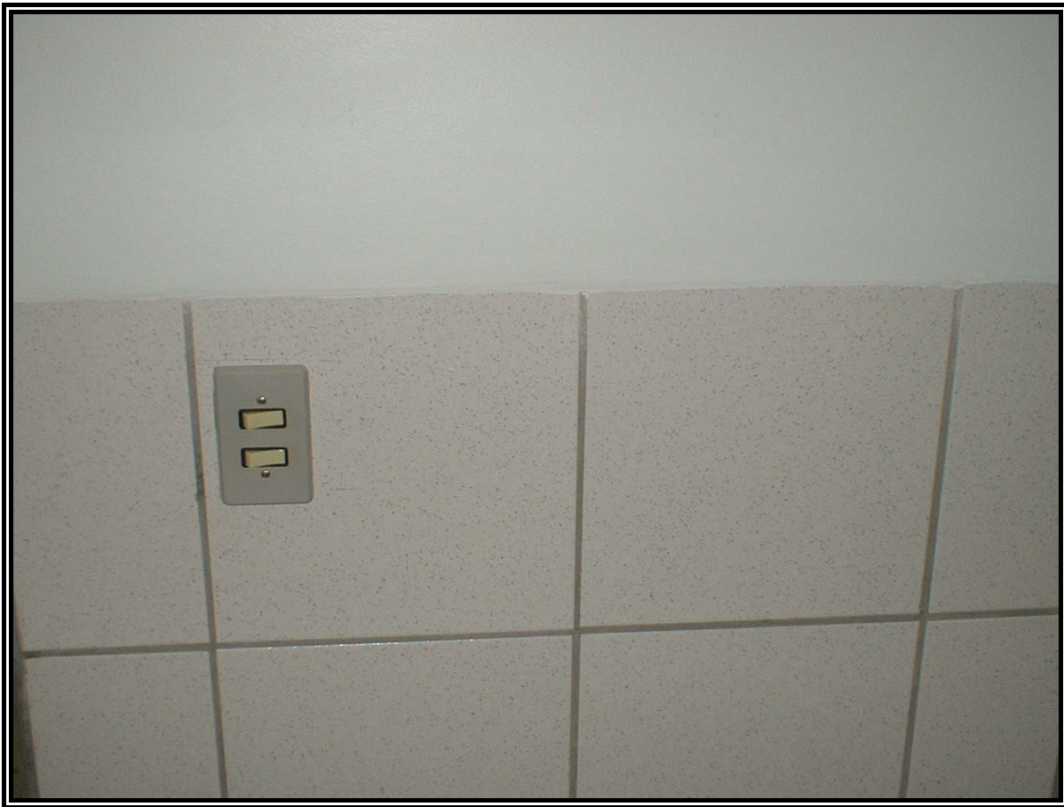
Figura 08- Detalhe da parede lateral do laboratório
