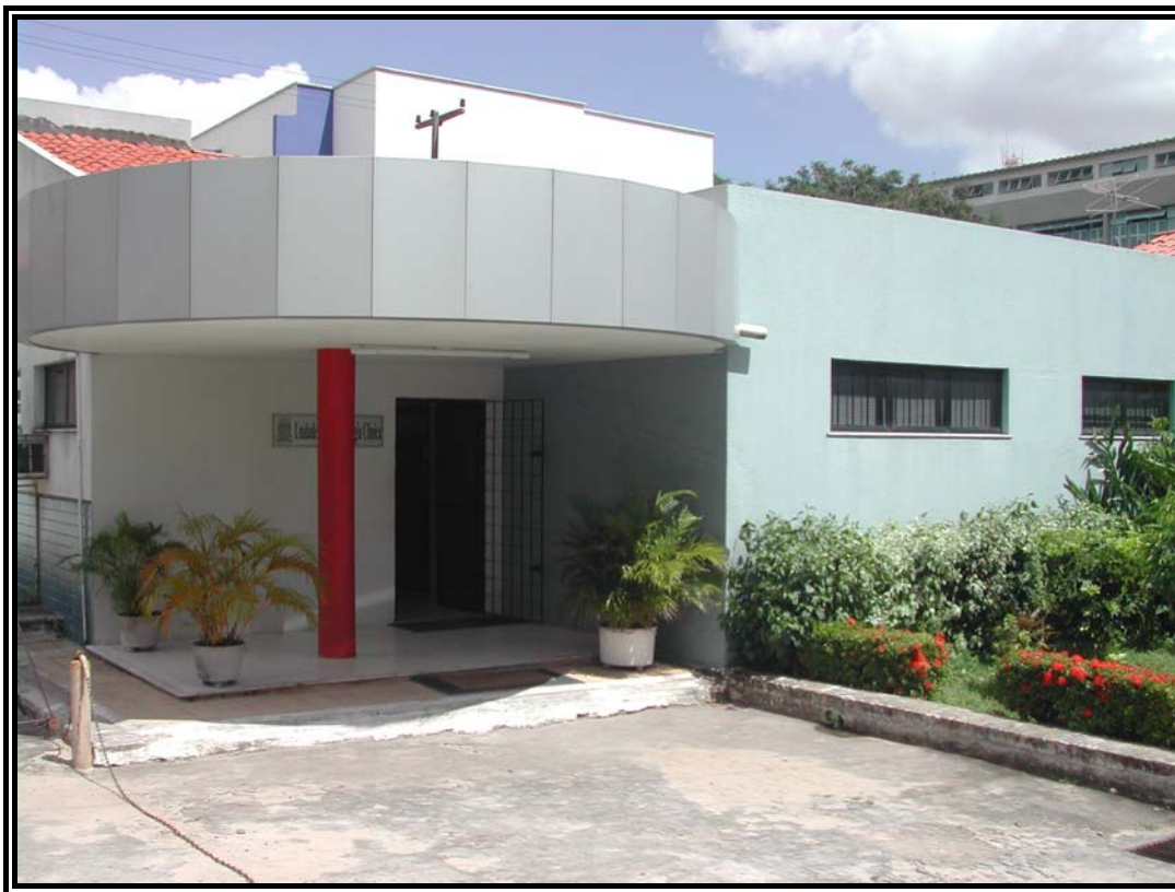
Figura 03- Prédio da UNIFAC - Entrada Principal
