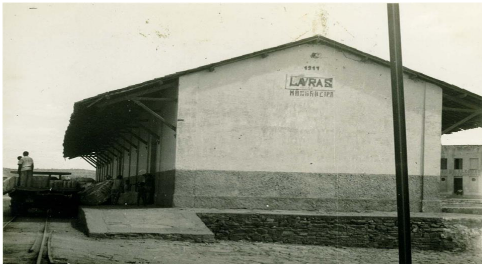
Figura 08 -Trabalhadores realizando um descarregamento de algodão na Estação Ferroviária de Lavras da Mangabeira - Linha-tronco - km 491,036 (1960) - CE-3150 - Inauguração: 01/12/1917 - Uso atual: desativada com trilhos.
