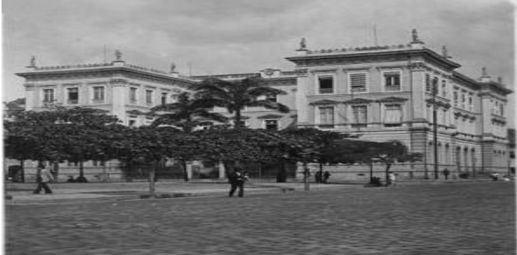
Figura 3 - Sede da Secretaria de Estado dos Negócios da Agricultura, Comércio e Obras Públicas, construída no final do século XIX- RJ.
