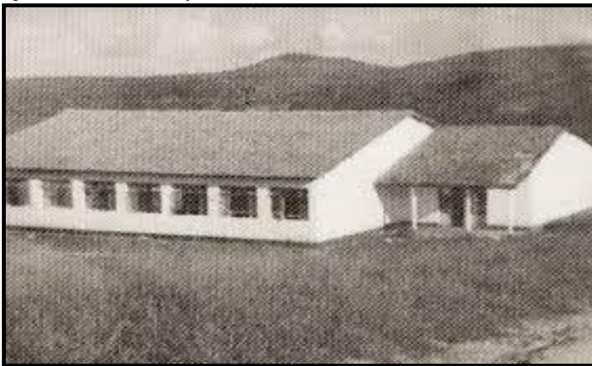
Figura 12 - Foto do Pavilhão de alojamento em 1960.
