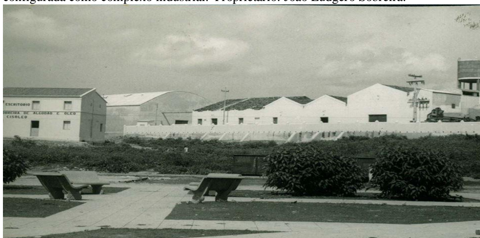
Figura 07 - Usina de beneficiamento de Algodão – CISOLEO, em Lavras da Mangabeira, configurada como complexo industrial. Proprietário: João Ludgero Sobreira.
