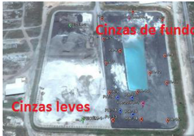
Figura 1.2 – Pátio de depósito das cinzas de carvão mineral.
