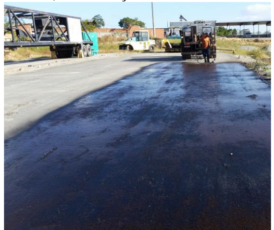
d) Aplicação da pintura de ligação
