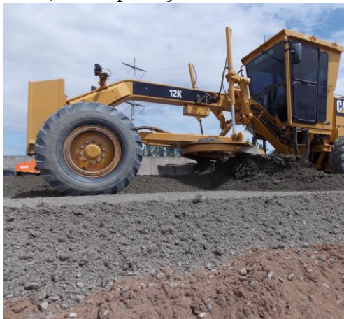
c) Construção da camada de base
