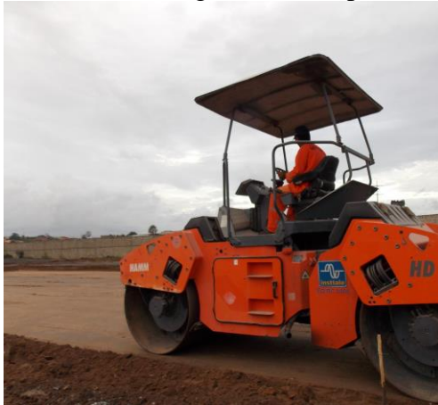
a) Compactação do subleito
