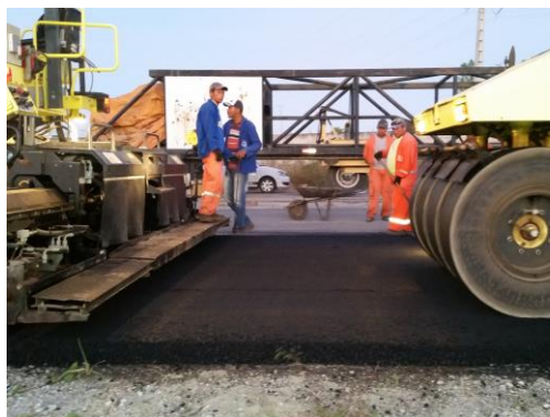
g) Compactação com rolo de pneu Fonte: Autora (2016).
