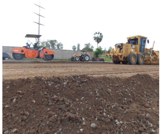
b) Construção da sub-base
