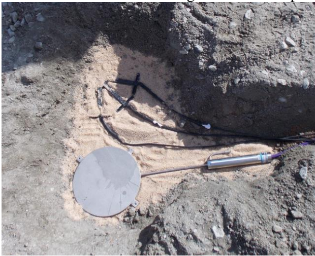
a) Instalação durante a construção
