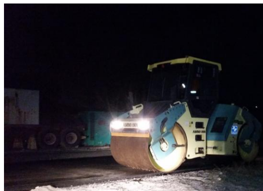
h) Compactação com rolo liso
