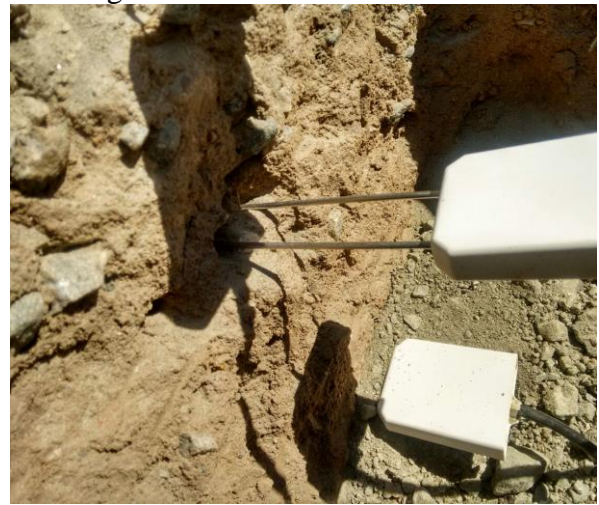
b) Instalação dos TDRs após a construção
