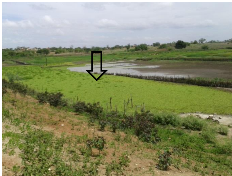
Figura 47 - Bacia hidráulica do reservatório Nova Vida, no mês de fevereiro 2014
