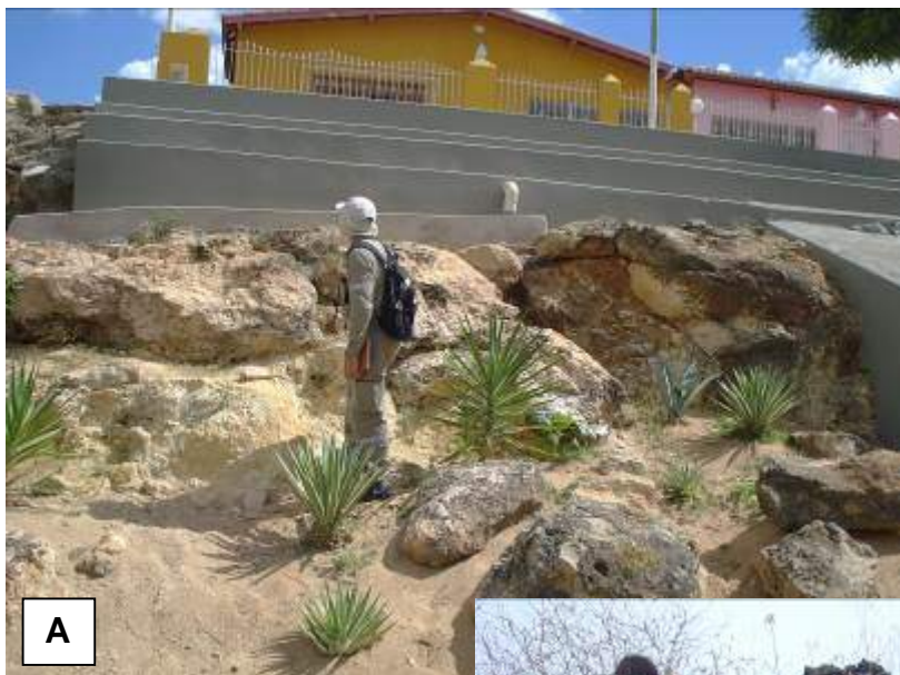
Figura 23 – Degradação dos depósitos de tufas.
