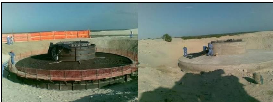
Figura 41 - Construção da base do aerogerador na Praia de Xavier
