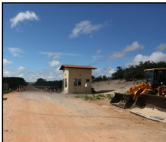
Figura 43 – Cancela que antecede o acesso ao parque eólico
