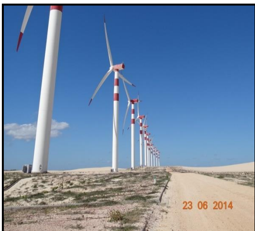
Figura 42 – Estrada de acesso às torres eólicas
