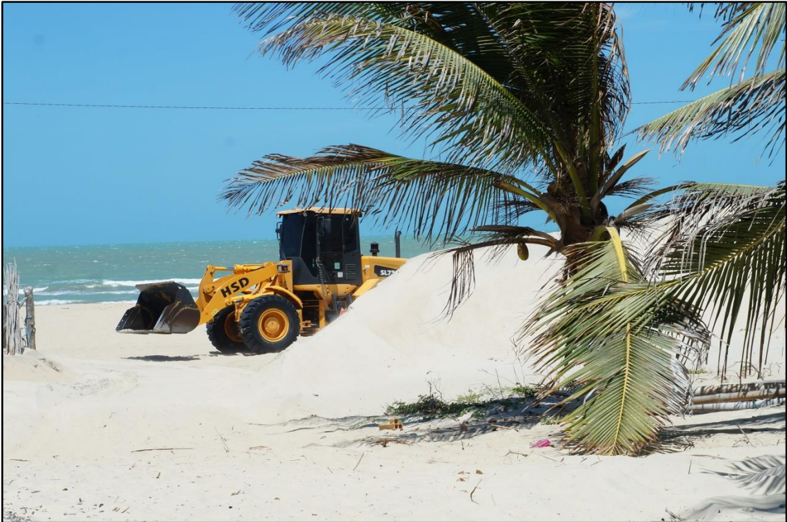
Figura 27 – Retroescavadeira retirando sedimentos da frente de uma residência
