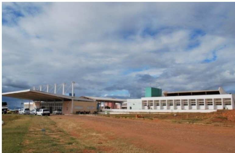
Figura 1- Prédio da Universidade Federal do Ceará no Cariri - 2010
