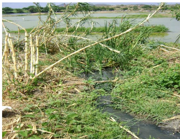
A6 - Escoamento de esgoto para o Rio Quixeramobim
