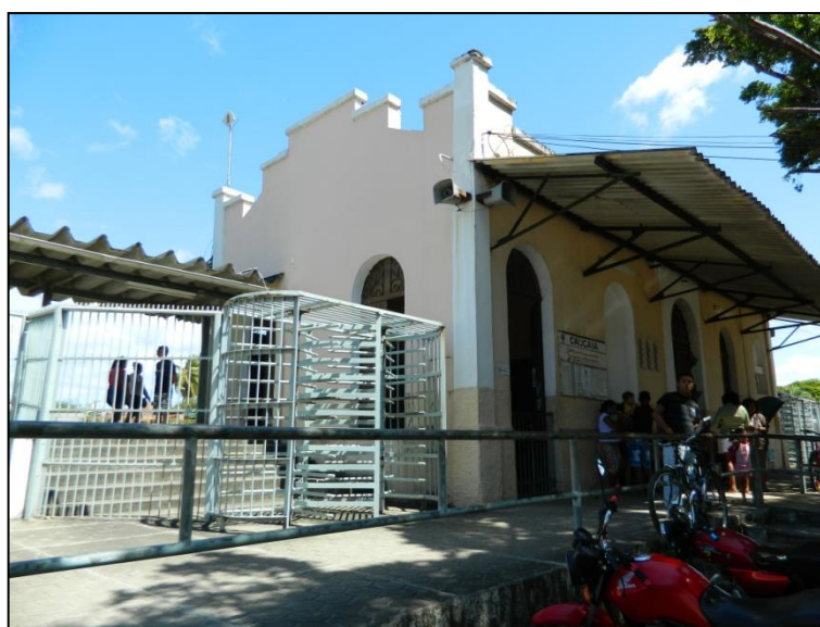
Figura 3 – Estação ferroviária de Caucaia
