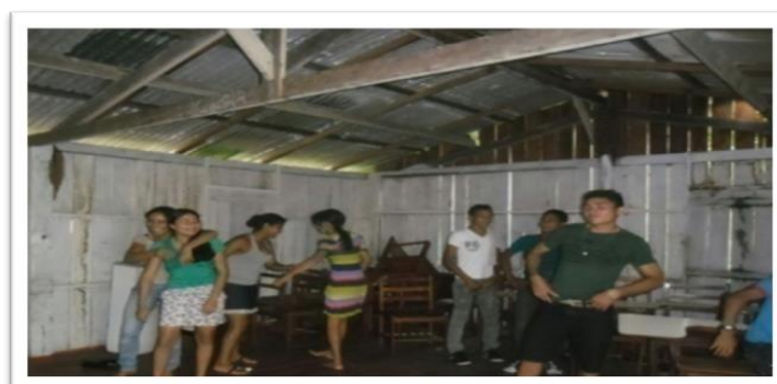
Figura 25- Infraestrutura das salas de aula
