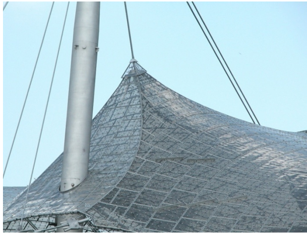
Figura 72 – Mastro de suporte dos cabos
