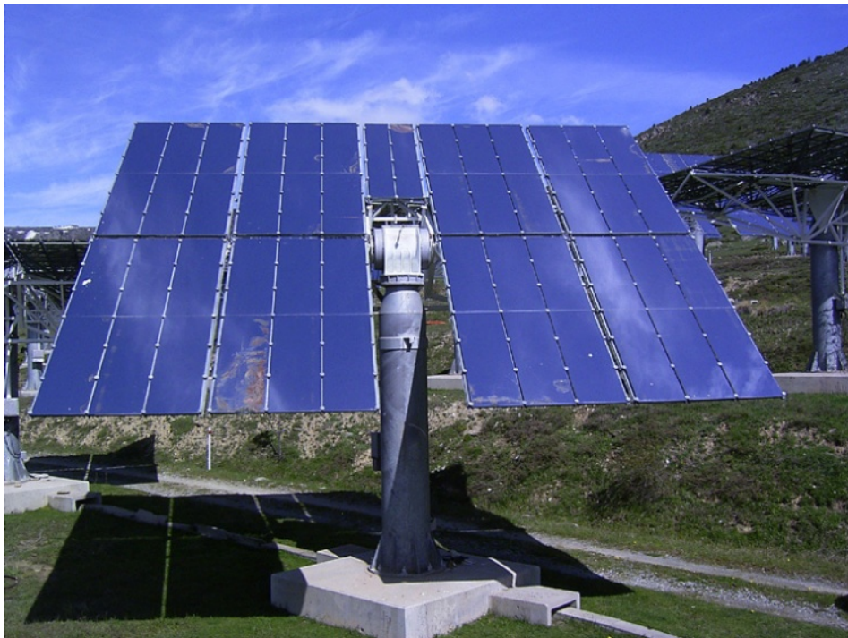
Figura 88 – Heliostato de uma usina de energia solar concentrada
