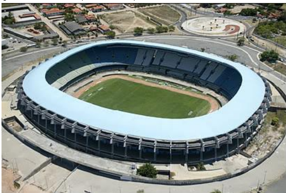
Figura 27 - Cobertura e pintura das arquibancadas do Castelão feitas nos anos 2000
