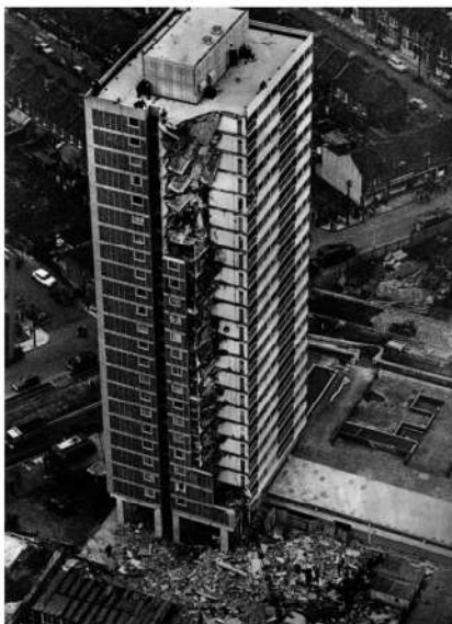
Figura 1 – Edifício Ronan Point após o colapso parcial.
