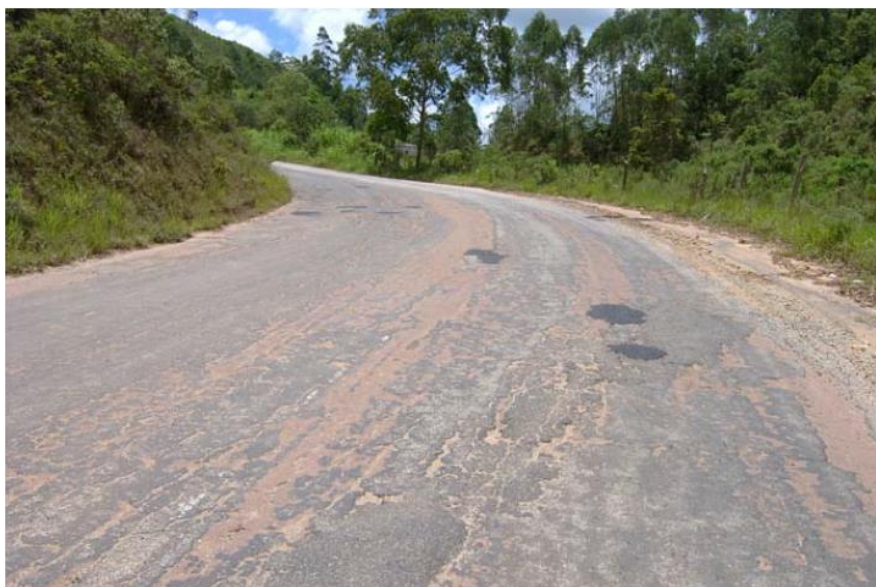
Figura 2.6 – Revestimento da RJ-148, construída em 1979, com base de solo-emulsão.
