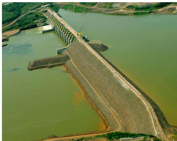
(a) Vista de jusante da barragem
