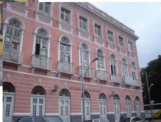
FIGURA 85 – Prédio da Associação Comercial do Ceará, em frente ao Passeio Público
