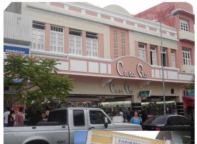
FIGURAS 57, 58, 59 – Fachadas Restauradas no entorno da Praça do ferreira
