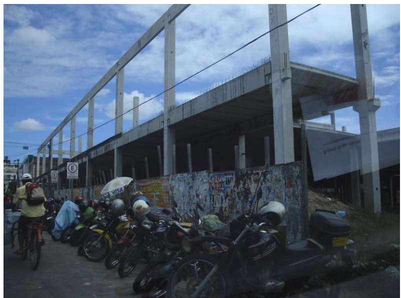
FIGURA 76 – Esqueleto da construção do Prédio para o Novo Beco da Poeira (idealizado pela APROVACE)
