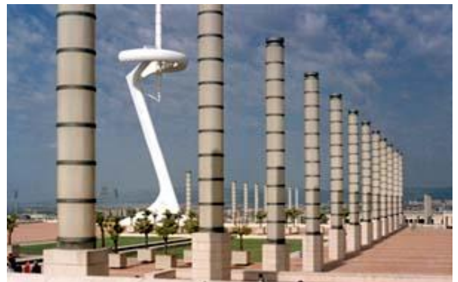
FIGURA 16 - Torre de telecomunicações de Montjuic, Barcelona
