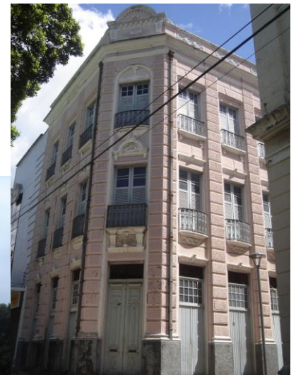
FIGURA 86 – Prédio do Restaurante Lions- Praça dos Leões
