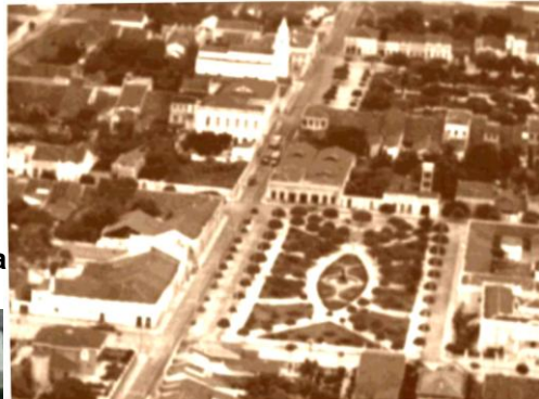
FIGURA 70 – Vista Aérea da Praça da Lagoinha atual
