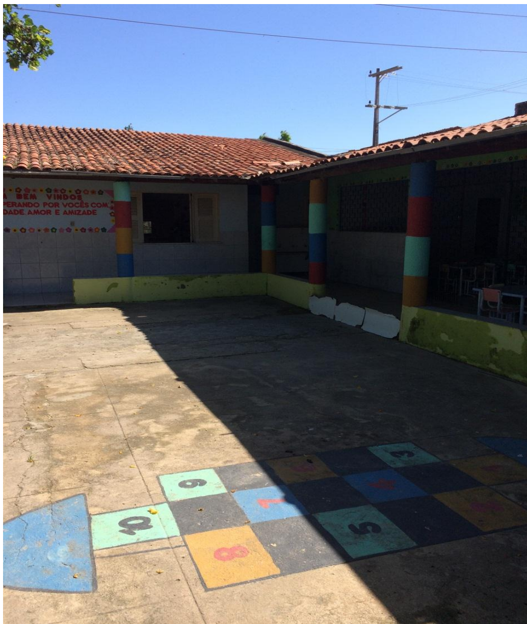
Figura 18: Área externa da creche municipal
