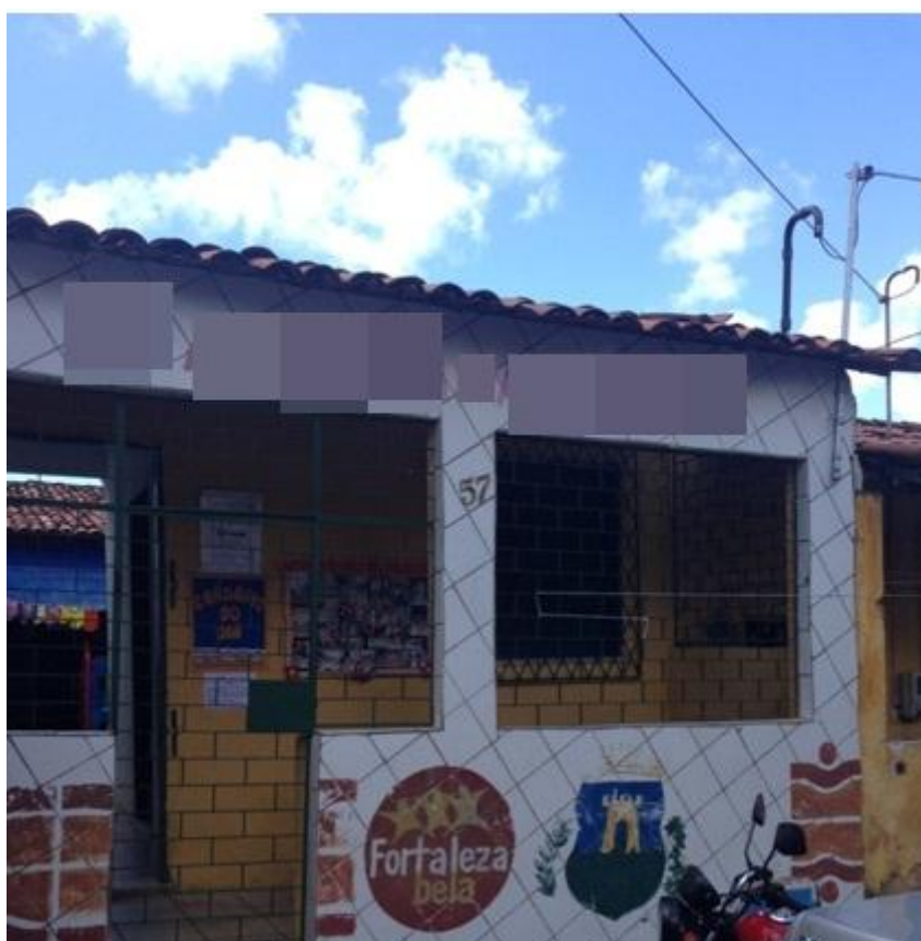
Figura 10 – Fachada do CEI Creche
