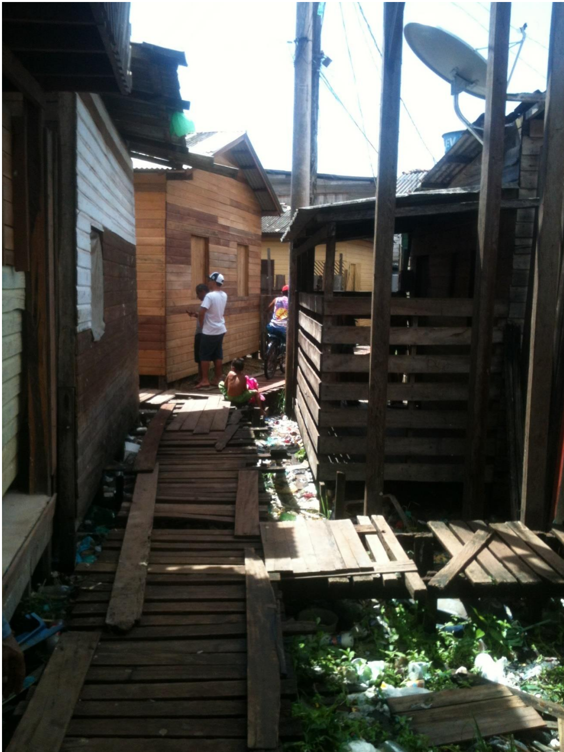
Imagem mostra a ponte/passarela da “parte de trás” da Baixada Perpétuo Socorro. Foto: Roberta Scheibe
