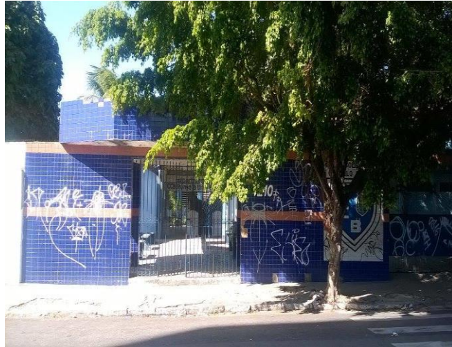
Figura 05 – Portão de acesso a escola de ensino médio regular Castelo Branco.
