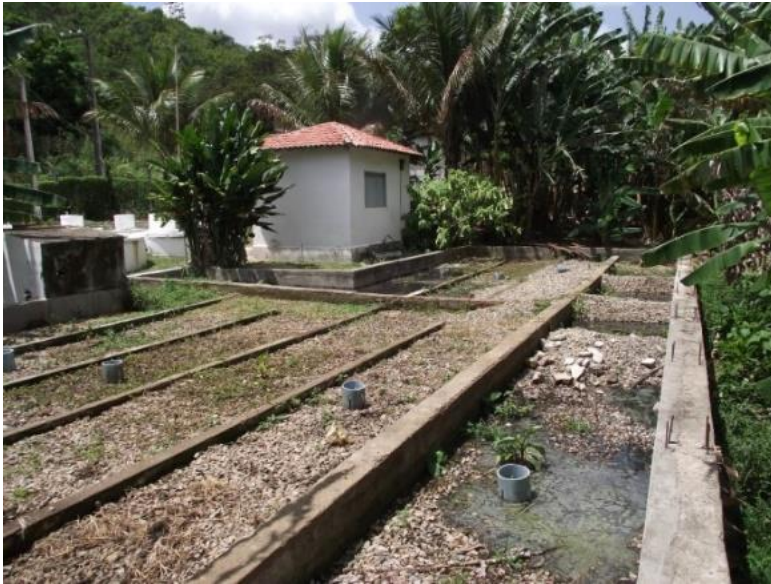
Figura 13-ETE Pernambucoquinho - Atualmente desativada
