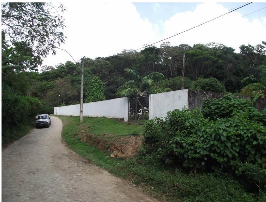
Figura 63-ETE 13 de Maio da Companhia de Água e Esgoto do Ceará (CAGECE)
