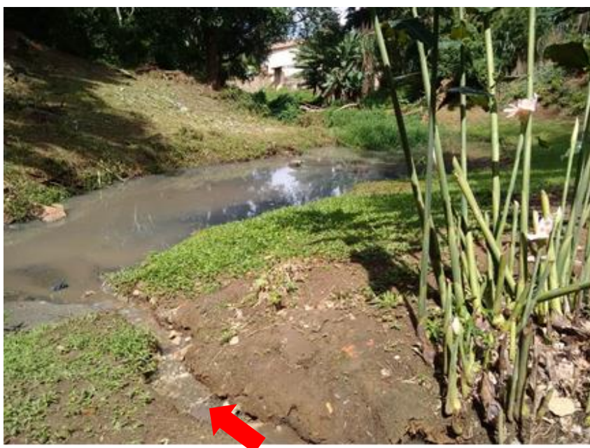
Figura 77-Detalhe do ponto de lançamento do efluente da ETE Pau do Alho
