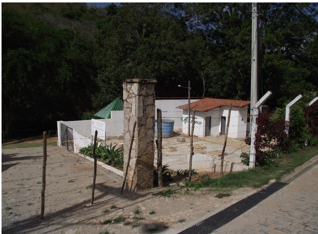
Figura 28-ETE Pau do Alho - na entrada do município de Pacoti
