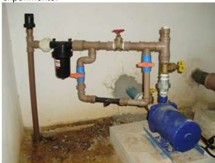
Figura 9 – Cabeçal de controle da irrigação e da fertirrigação utilizado na realização do experimento.
