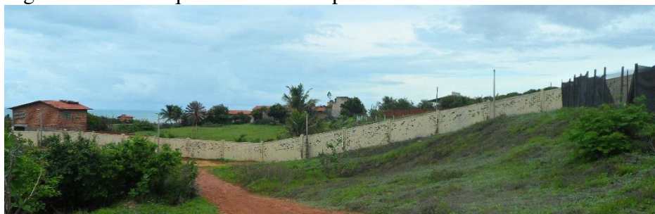
Figura 18 – Muro que delimita o empreendimento.
