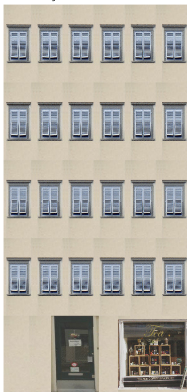
(b) A imagem lembra construções comuns em centros comerciais, em que uma loja ocupa o piso do prédio e apartamentos residenciais ocupam os andares superiores.
