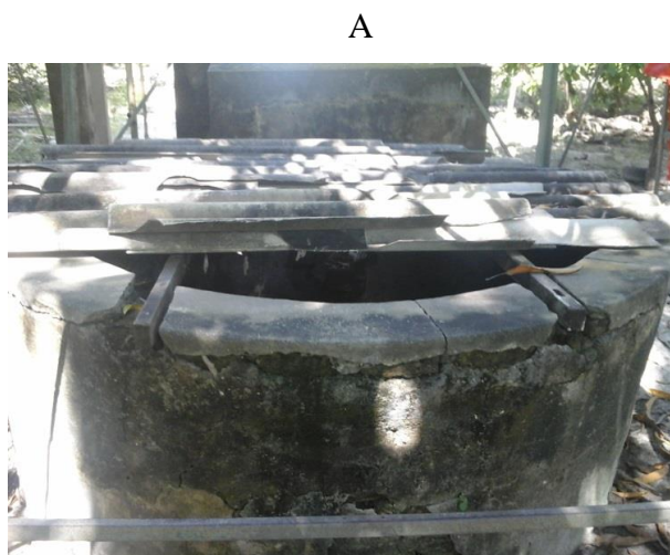
Figuras 5.9 – (A) Más condições de isolamento; (B) Poço com presença de matéria orgânica na superfície da água.
