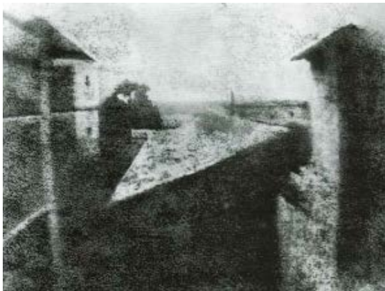
Figura 1 – Vista da janela em Gras, 1827
