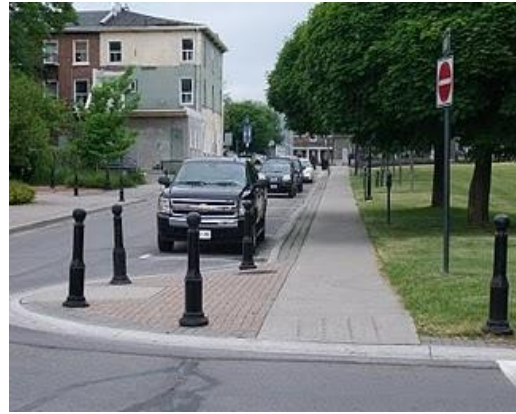
Figura 2.8: Calçada nivelada com a rua. Fonte: STREETCITIZENSHIP, 2010.
