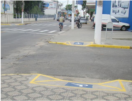
Figura 2.7: Rampa acessível Fonte: VALELAR, 2010.
