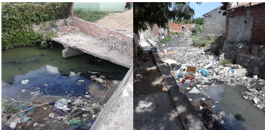
Figura 5-17 Visualização de lixo e esgoto no canal nos pontos P2 (a) e P3 (b), respectivamente.
