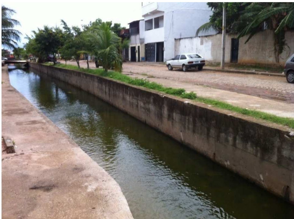
Figura 4-4 Vista do canal que deságua no reservatório Santo Anastácio em Fortaleza CE
