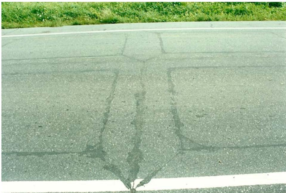
**Figura 2.4:** Conjunto de Laços Indutivos Responsáveis pelas Contagens Contínuas Instalado no Pavimento.
