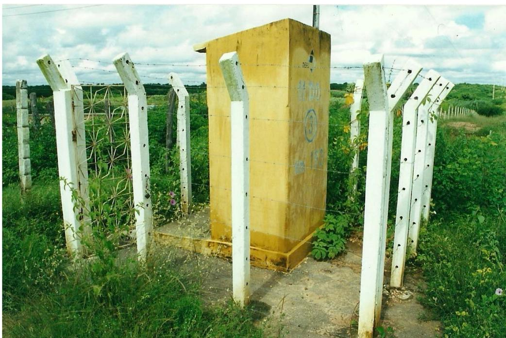
**Figura 2.3:** Posto de Contagem Permanente Protegido por Abrigo de Concreto
