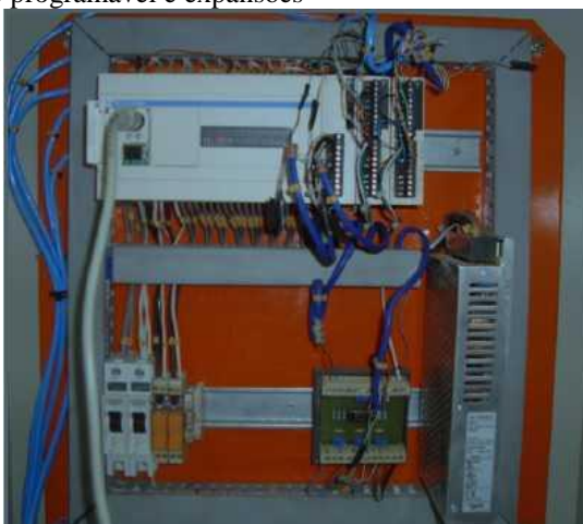
Figura 4.7 - Controlador lógico programável e expansões
