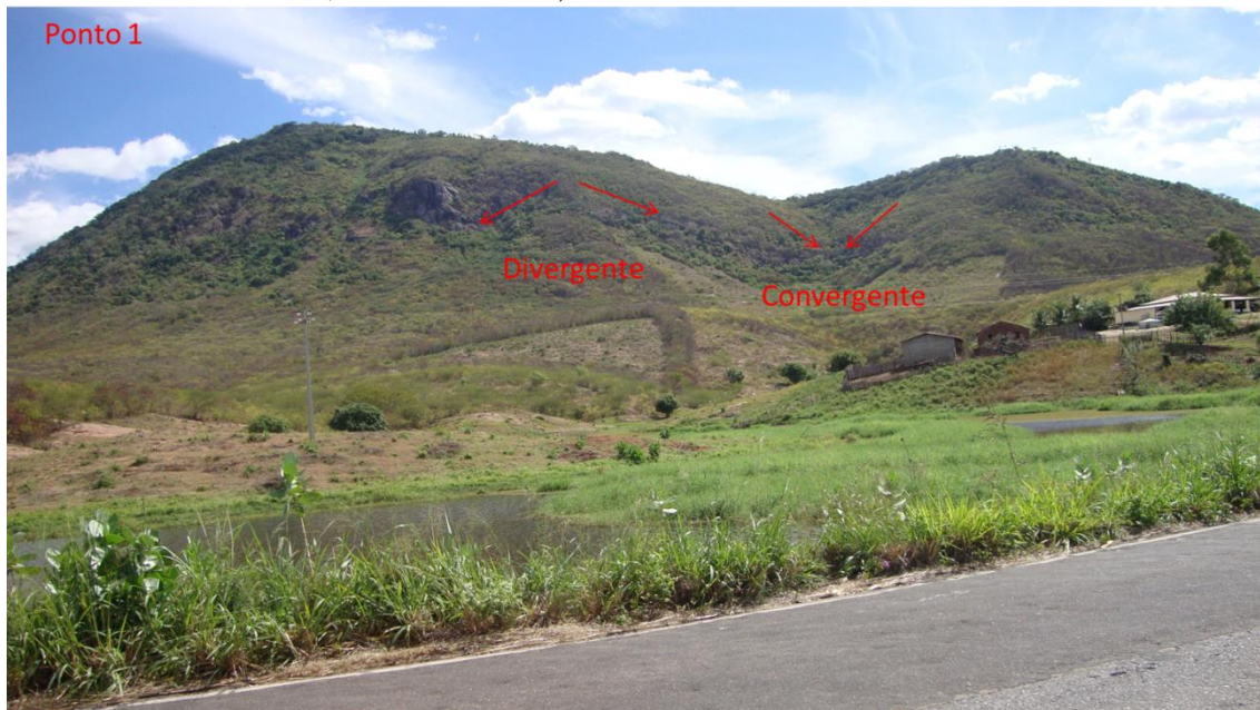
Figura 27 – Ponto de validação das curvaturas horizontais da vertente. (Coordenadas das fotos: 442.990 mE, 9.339.552 mN ).
