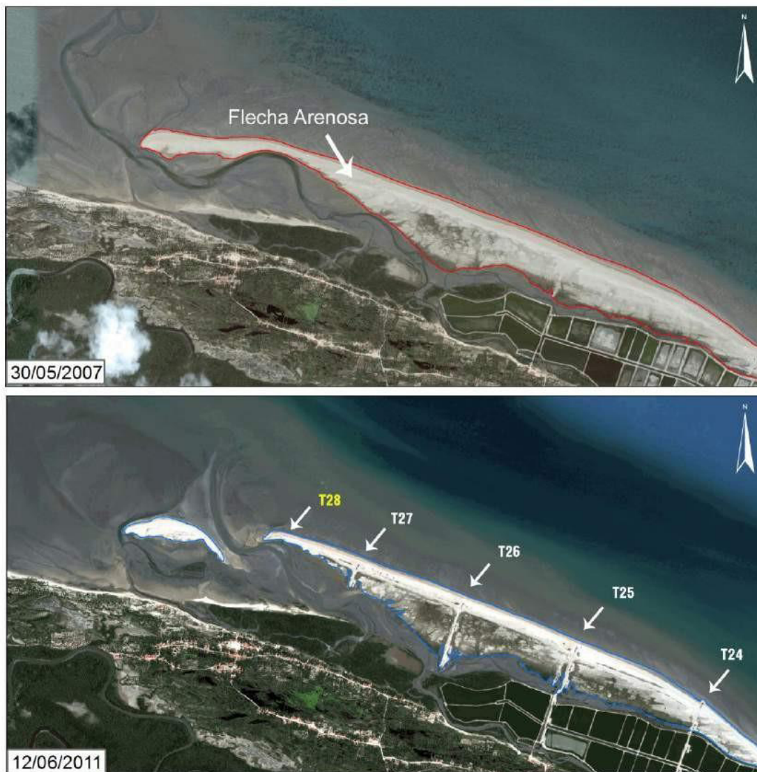
Figura 36. Imagem de satélite Imagens do Sensor Quickbird 2007 e 2011 comparativa antes e depois da instalação do parque eólico Volta do Rio.
