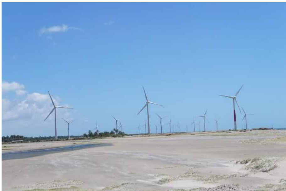
Figura 30. Vista da Unidade de Energia Eólica Volta do Rio.
