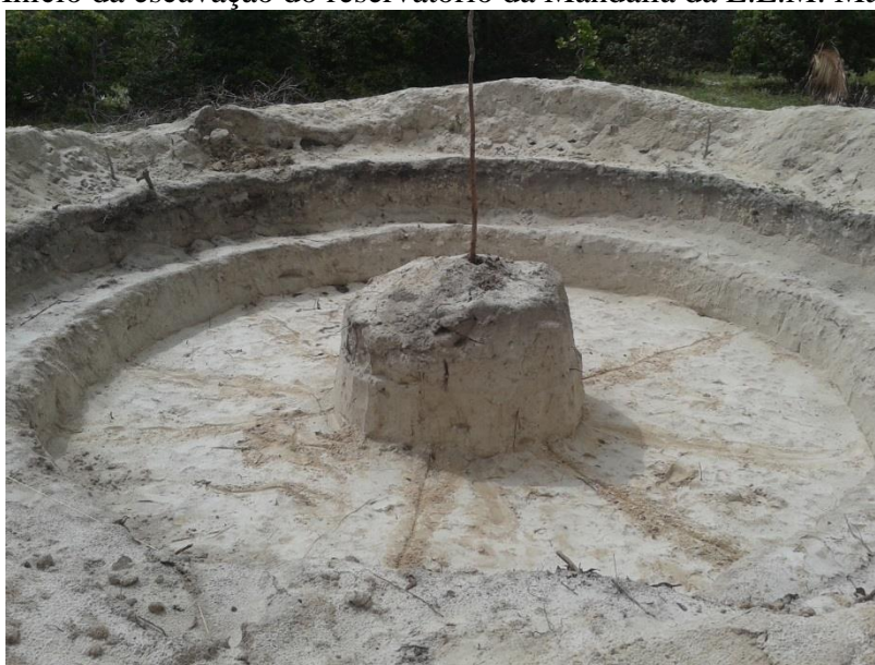
Figura 25– Início da escavação do reservatório da Mandalla da E.E.M. Maria Nazaré de Sousa
