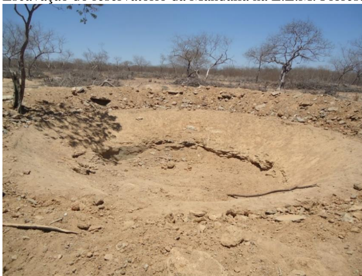
Figura 19 – Escavação do reservatório da Mandalla na E.E.M. Florestan Fernandes
