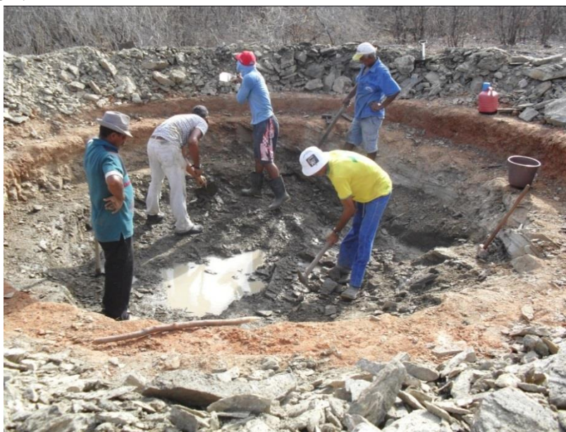
Figura 13 – Construção do reservatório da Mandalla na Escola João dos Santos Oliveira – Madalena/CE.
