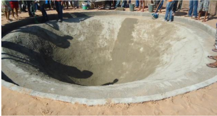
Figura 2 – Reservatório de água da Mandalla
