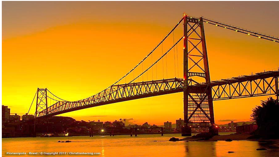
Figura 1 – Ponte Hercílio Luz (SC)
