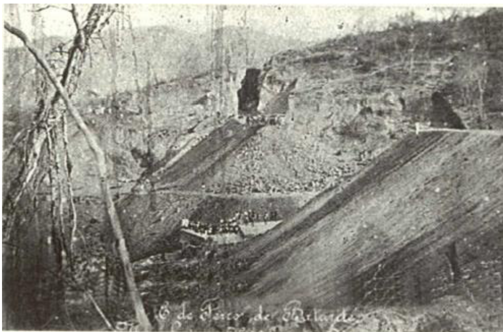
Figura 43: Construção na “ladeira do Itapahy, 1879.
