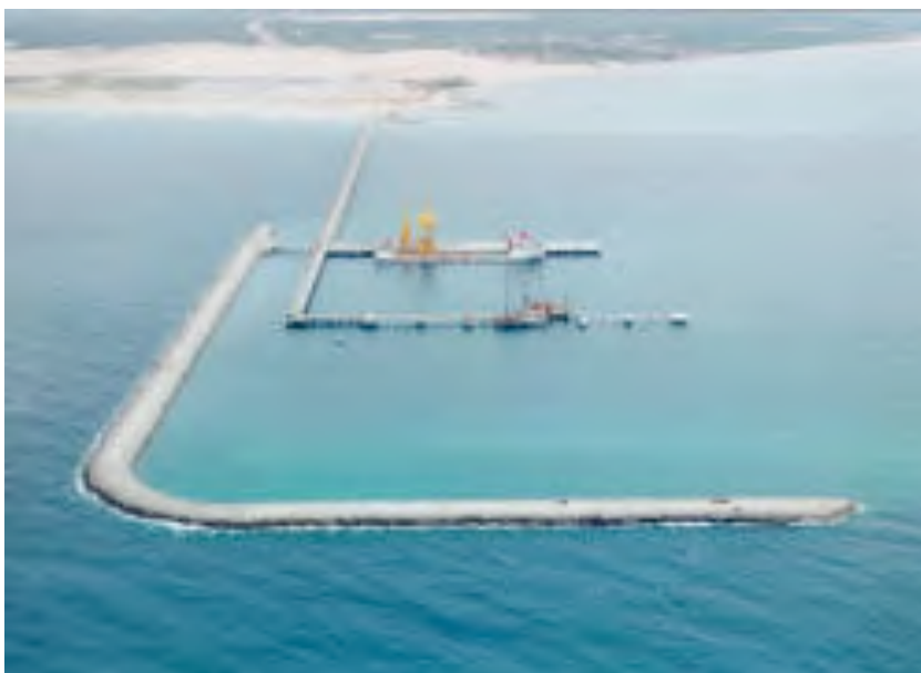
Figura 3. Vista aérea do Terminal Portuário do Pecém.
