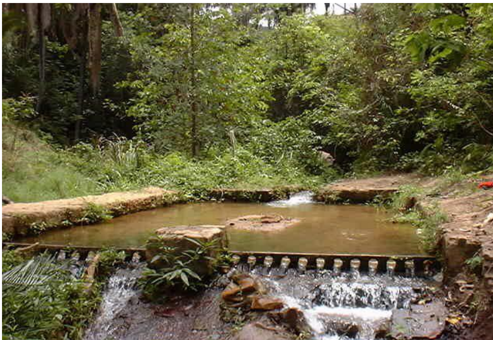
Figura 6.1 – Tanque de distribuição no córrego da Fonte Bom Jesus construído por Francisco Sampaio durante a década 1920
