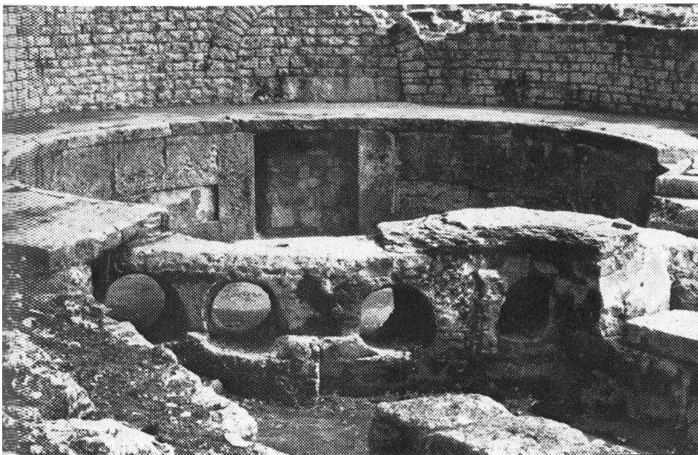
Figura 6.2 – Sistema de medição de vazão de água construído no Império Romano na Cidade de Nîmes-França, aproximadamente 2000 anos antes de hoje. Fonte: LANDELS 1979
