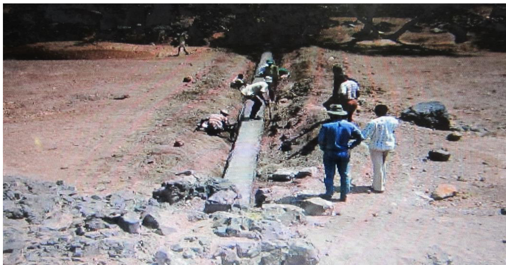
Figura 1 - Aspecto da construção de uma barragem subterrânea no Quênia-África
