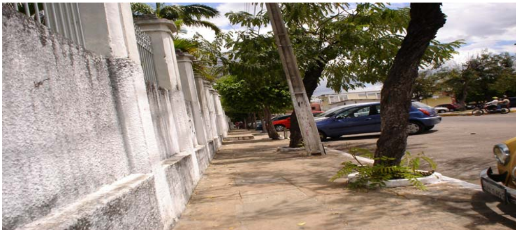
Fotografia 3 Calçada em volta do hospital, sem rebaixamento de meio-fio e com obstáculos por todo o percurso
