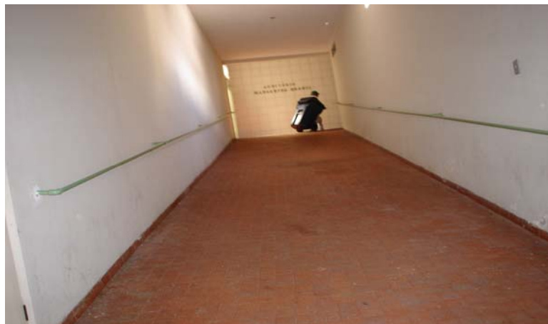
Fotografia 8 Rampa de acesso interno
