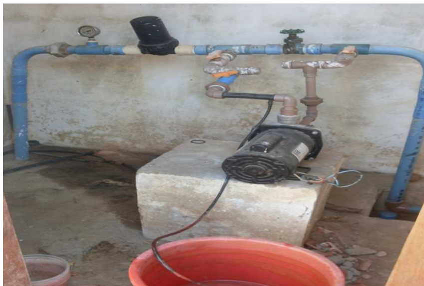
Figura 2 - Cabeçal de controle com sistema de injeção de fertilizantes, Fortaleza, Ceará, 2010.
