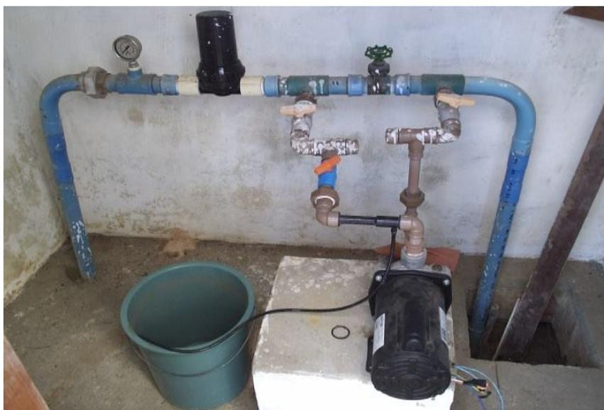
Figura 02 – Cabeçal de controle e o sistema de injeção de fertilizantes, Fortaleza, Ceará, 2008.
