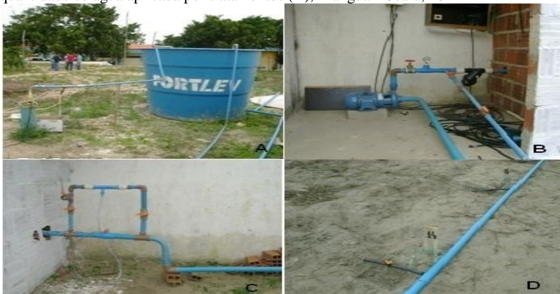
Figura 8 - Detalhes do sistema de irrigação: Cisterna de 5.000 L (A); Conjunto motobomba de 5 CV, cabeçal de controle com manômetro para controle da pressão e filtro de disco (B); injetor de fertilizantes Venturi (C); registro para controle da quantidade de água aplicada por tratamentos (D), Tianguá - Ceará, 2014
