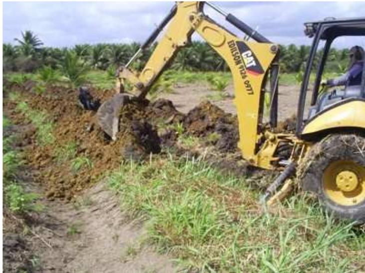
**Figura 2.3.** Abertura do dreno coletor
