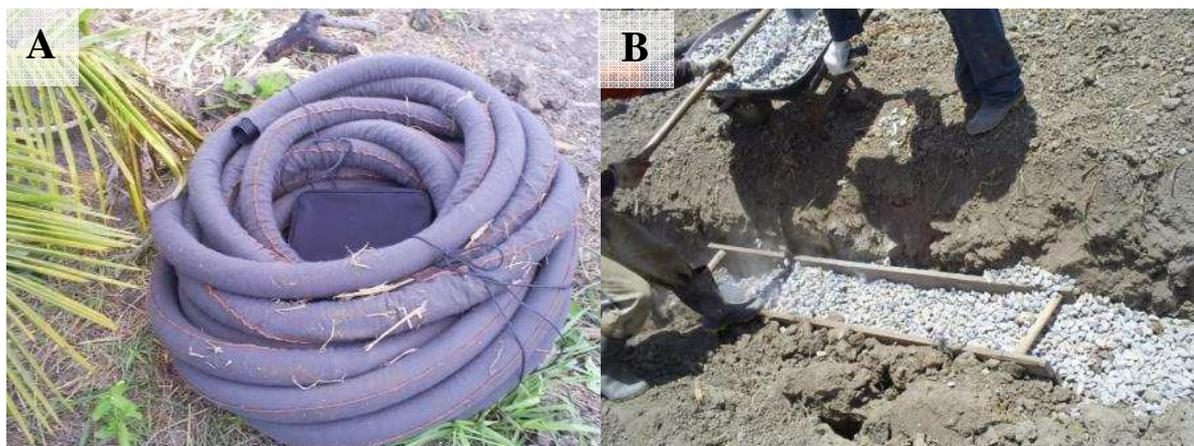
**Figura 2.5.** Tubo drenoflex envolto com manta bidim OP 20 (A), caixa de brita servindo como envelope do tubo de drenagem (B)
