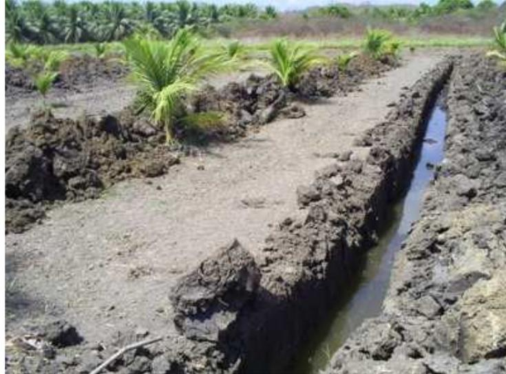
**Figura 2.4.** Vista de uma das valas para a instalação dos drenos subterrâneos
