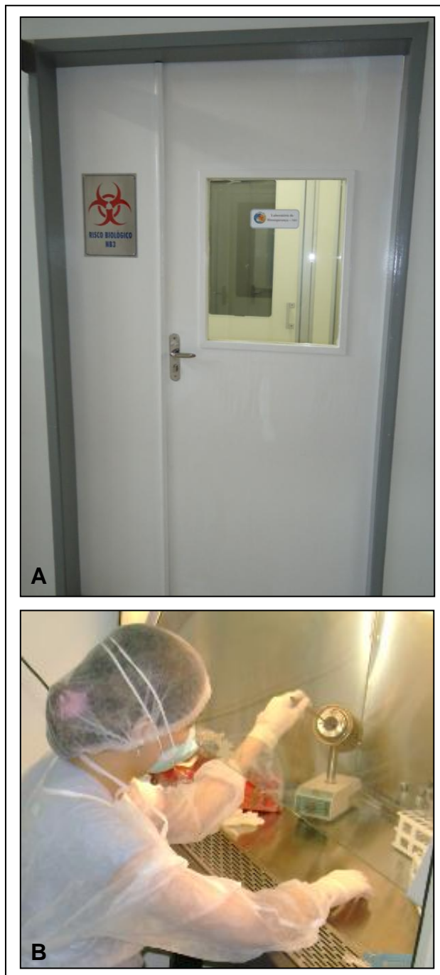
Figura 13. A. Sala de nível de biossegurança 3 (NB-3); B. Cabine de segurança biológica classe II. Fonte: CEMM, 2010.
