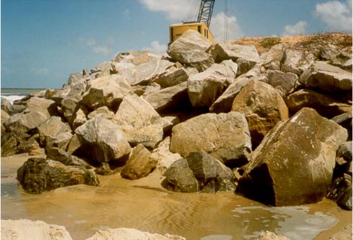
FIGURA 3.9 – Colocação da camada de 1,5 metros de pedra, na construção da “sea wall” (1992)
