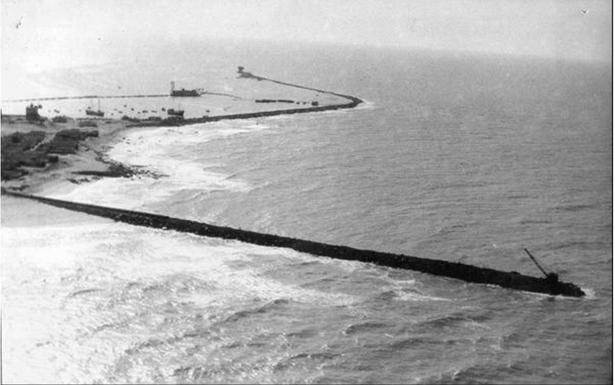
FIGURA 4.9 - Foto da área quando da construção do espigão de contenção em 1964 (Fonte: Pitombeira, 2005).
