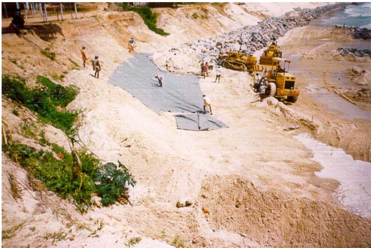
FIGURA 3.6 – Implantação da bidin na construção da “sea wall” em 1992.
