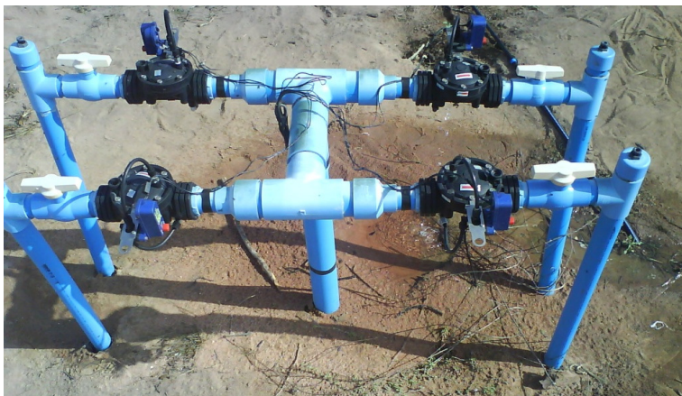
Figura 4.2 – Foto do cavalete e respectivas válvulas de controle
