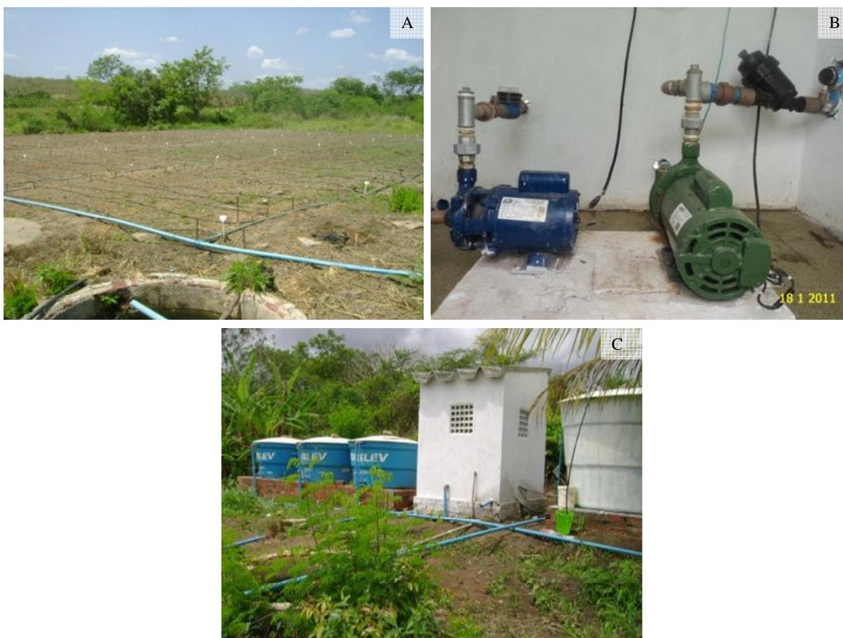
**Figura 3.4** - Sistema de irrigação por gotejamento (A); das bombas centrífugas de  $\frac{3}{4}$  e 2 cv (B); e das caixas de 2000 e 5000 L (C) na área experimental, Pentecoste-CE
