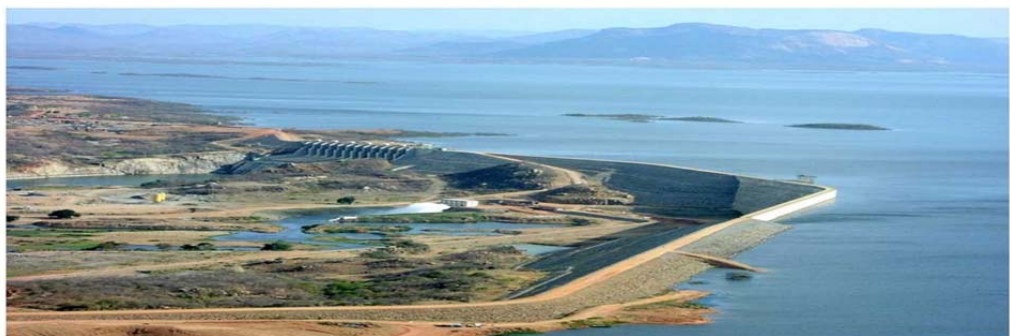
Figura 10. Reservatório do Castanhão. Fonte: DNOCS, 2011
