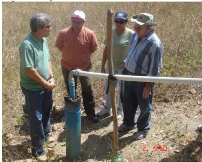
Figura 4 – Poço raso tubular construído no Neossolo
