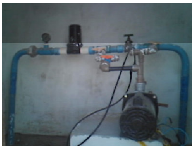
Figura 15 Cabeçal de controle utilizado nas fertirrigações.
