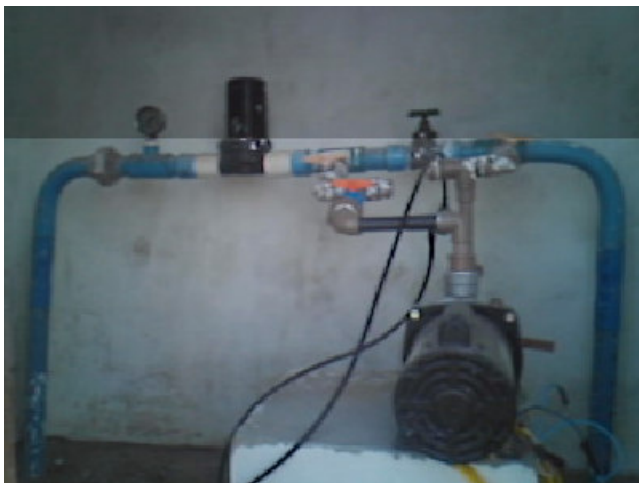
Figura 2 – Cabeçal de controle utilizado nas fertirrigações.
